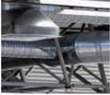
Eine Vielzahl der **BEAMCLAMP** Produkte ist für den Einsatz in der Gebäudetechnik geeignet. Wir bieten diverse Lösungen für den Anschluss von gebäudetechnischen Anlagen auf, an oder unter Stahlträgern, ohne dass Bohr- oder Schweißarbeiten erforderlich sind. Auch die Befestigung von Rohr- und Stromleitungen für Heizung, Lüftung und Klimatechnik sowie dem Brandschutz ist mit unseren Produkten möglich.
