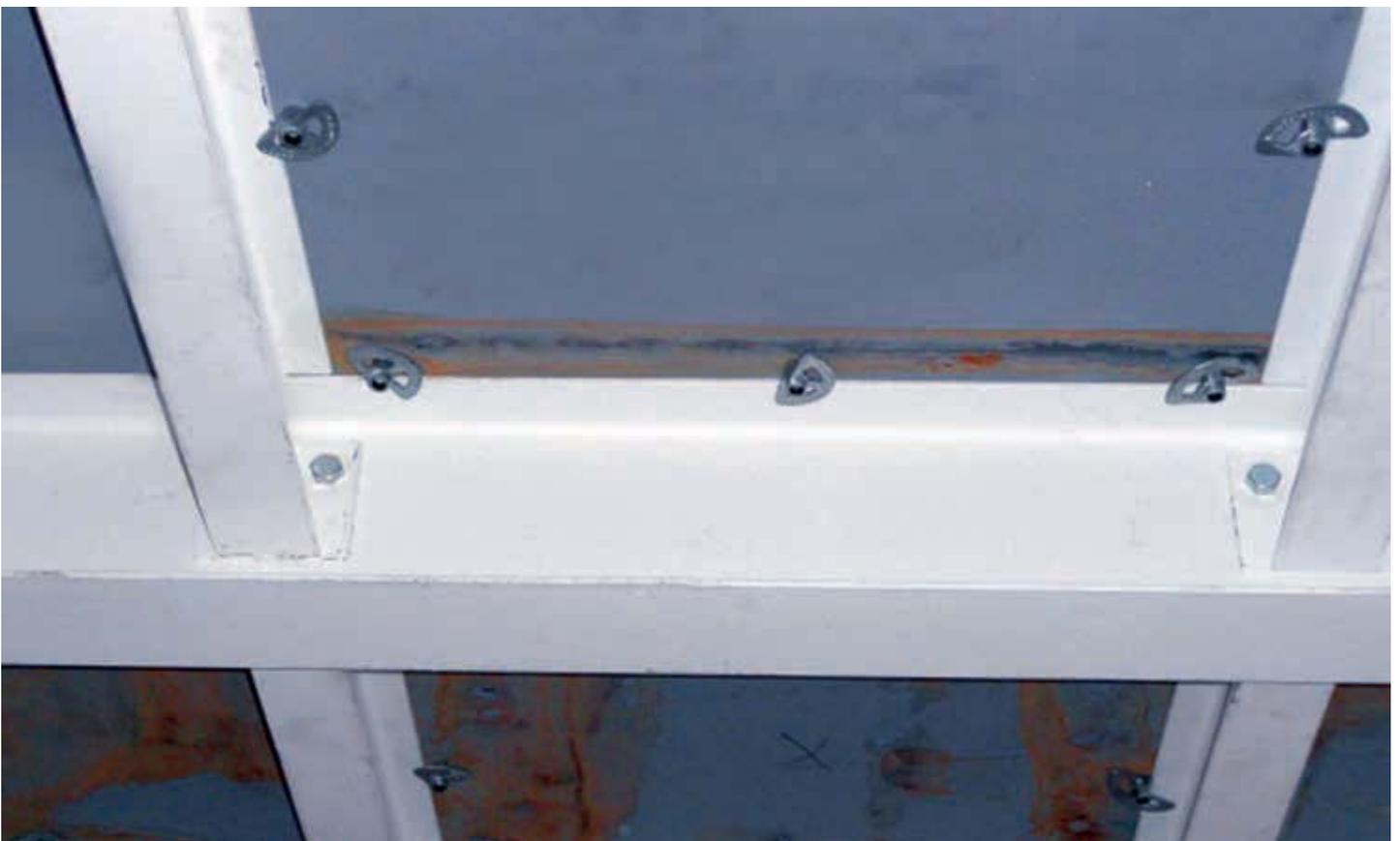
In dieser Anwendung wurde die Tränenblechbefestigung **FLOORFIX HT** genutzt, um den Boden des Zwischengeschosses an der Stahlkonstruktion zu befestigen. Für die Montage sind weder der Zugang zur Unterseite der Konstruktion noch Bohren oder Schweißen der Stahlträger notwendig.
