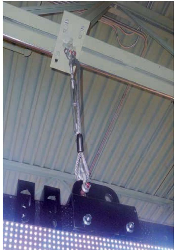
Die BK Klemme zur Befestigung von Anschlag- und Befestigungspunkten ist in dieser Anwendung für die Aufhängung einer Videowand in einem großen Einkaufszentrum genutzt worden. Diese Klemmen können aufgrund ihrer variablen Befestigungsbreite zur Befestigung an unterschiedlichen Stahlträgern bestehender Stahlkonstruktionen verwendet werden.
