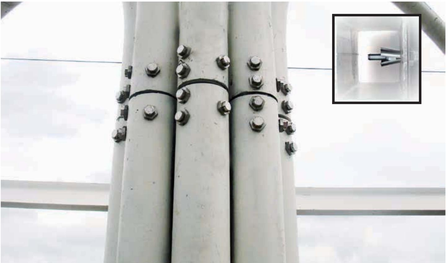
**BOXBOLT** Hohlprofilbefestigungen sind in dieser Anwendung für die Verbindung einer Rohrkonstruktion genutzt worden. Die Verbindung bietet einen hohen Sicherheitsfaktor und vermittelt einen sauberen äußeren Eindruck.
